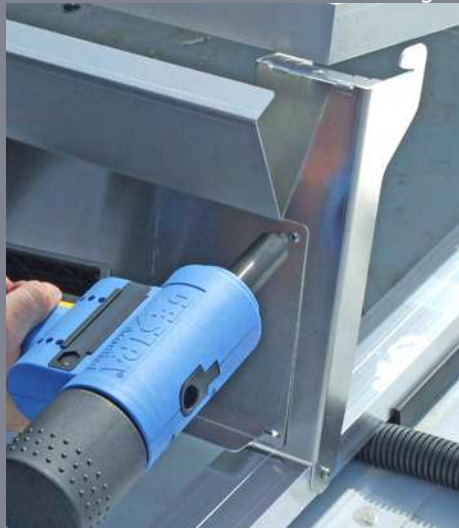
Detail hinterer Modulträger
