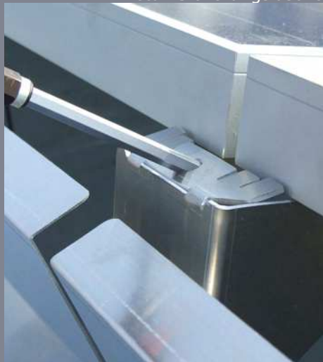
Detail Sicherungslasche
